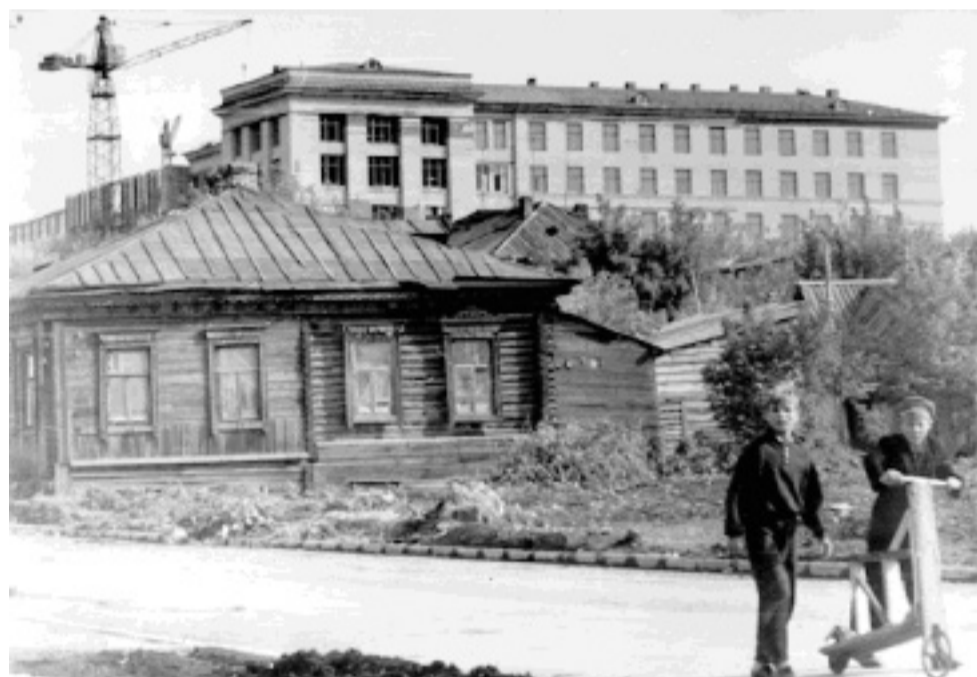
Строящийся корпус Политеха
